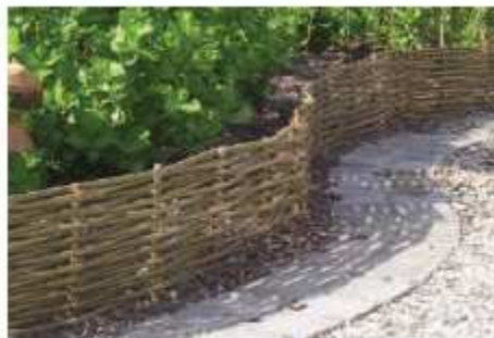
Structure en branches de saule tressées horizontalement. Bordure à fixer avec tiges à insérer dans le tissage
