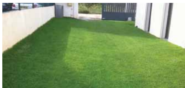
Repousse de l'herbe entre les mailles (photo prise 1 mois après la pose)
