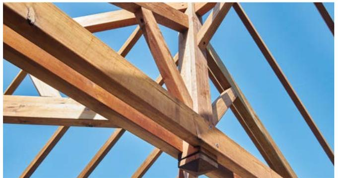
Les fermes sont constituées d'entrails et arbalétriers de section 68 x 145 mm, poinçons de section 140 x 140 mm, et liens de section 68 x 90 mm.
