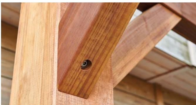
Liens de contreventement de section 68 x 90 mm sur les poteaux. Fixations : vis inox structurales de type charpente.
