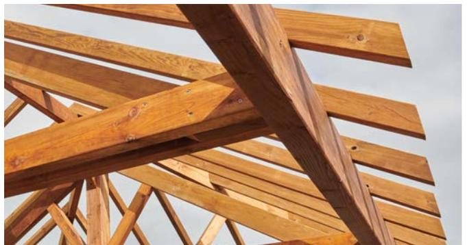
Pannes sablières en lamellé-collé de section 80 x 280 mm permettant de réaliser de grandes portées (5 ou 6 m).
