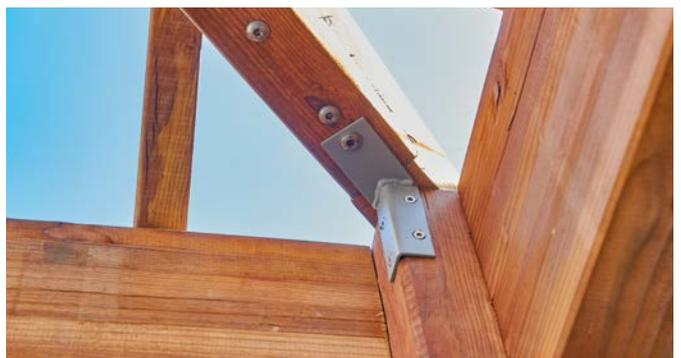
Équerres de liaison entre arétrier et tête de poteau (acier galvanisé à chaud laqué).
