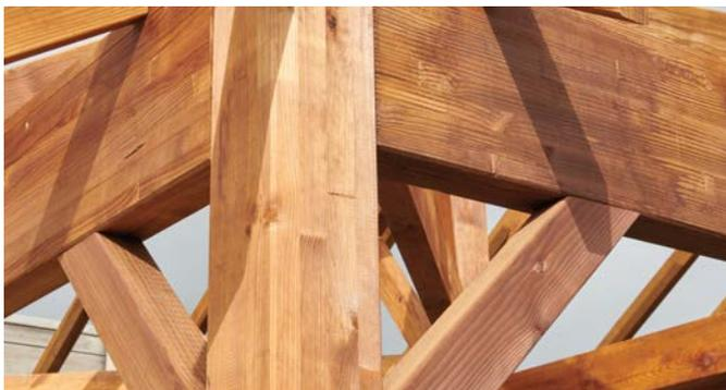
Poteaux en lamellé-collé de section 140 x 140 mm pour garantir une excellente stabilité dimensionnelle.
